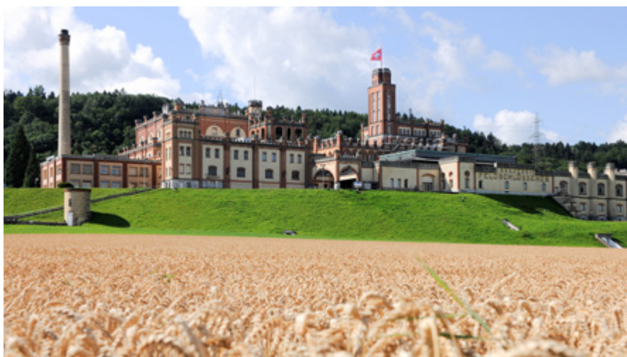
Heizen mit industrieller Abwärme in der Bierbrauerei von Feldschlösschen, gefördert mit dem Programm «Wärmeverbünde».
