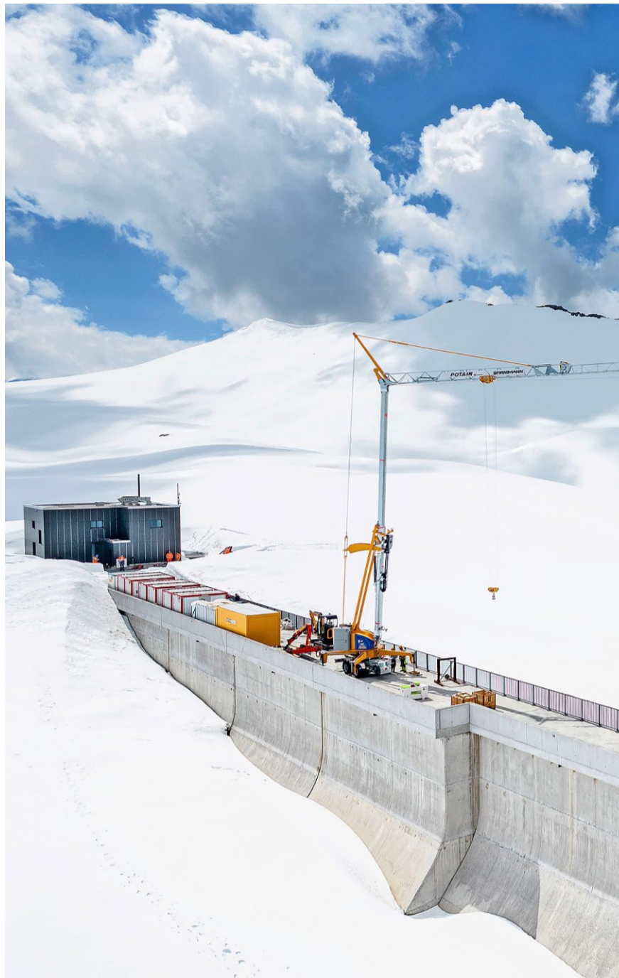
An der Staumauer des Muttsees baut Axpo eine Solaranlage.
